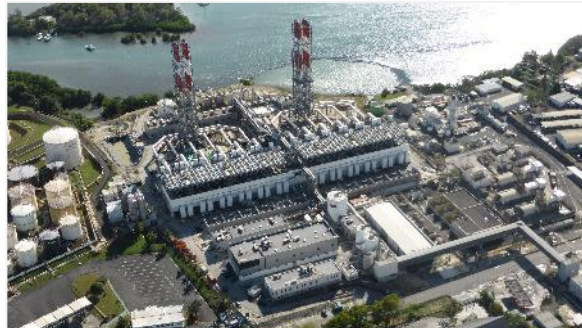
La centrale de Pointe Jarry en Guadeloupe – 220 MW – livrée en 2015
